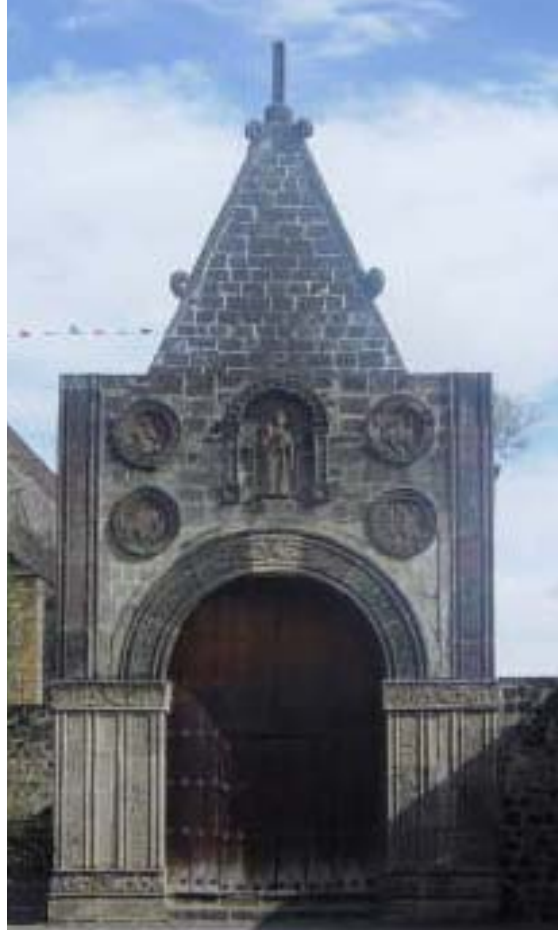
Fig. 15: capilla posa, Calpan (Puebla)
